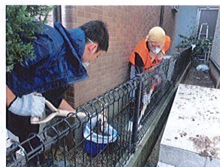
被災地域での泥出し
